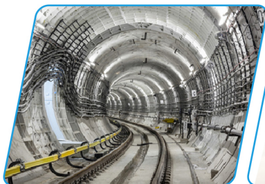
隧道工程测绘
